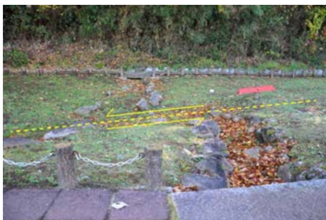
図2-6 石組みの水路が丹那断層 点線を境に地面が食い違っている。
