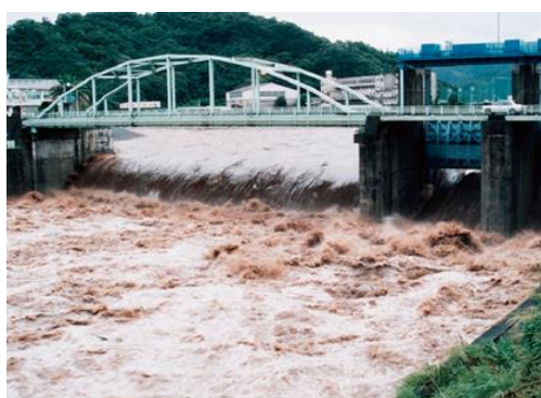
解放面が二つある。水量によって右側の稼働扉を開く。
