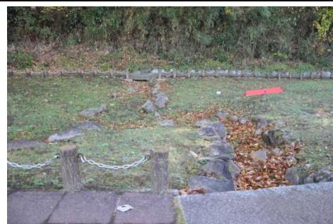
北伊豆地震で生じた横ずれ
