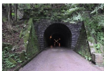
『伊豆の踊子』の天城隧道
