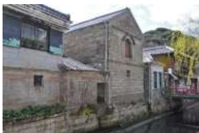
伊豆石の街並み (下田市)
