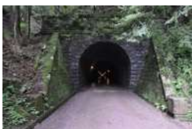
『伊豆の踊子』の天城山隧道
